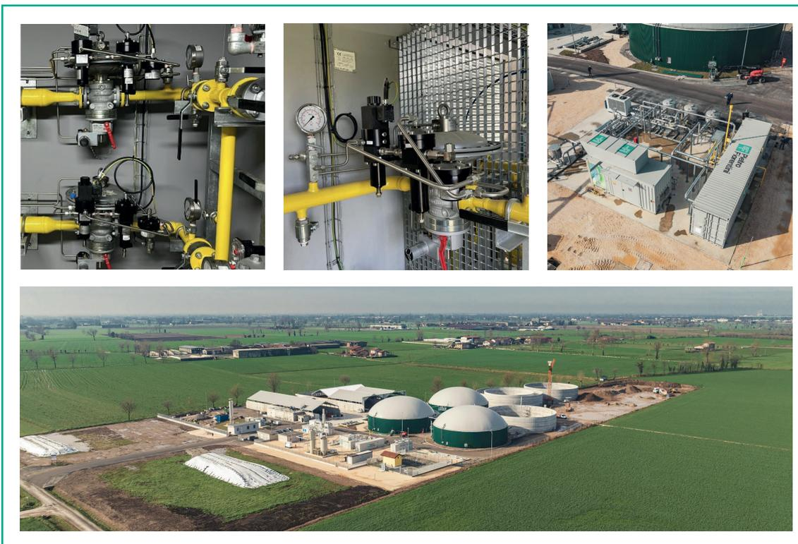
**Figura 6** Estaciones de mejora e inyección de biogás (GNR)
