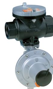
Le **Dilock** est un dispositif de sécurité, également appelé clapet de sécurité, adapté pour interrompre rapidement le flux de gaz lorsque la pression atteint une valeur de consigne d'étalonnage. Ce dispositif est principalement utilisé dans les réseaux de distribution de gaz à moyenne et basse pression. Le Dilock est **Hydrogen Ready** pour le mélange NG-H2.
