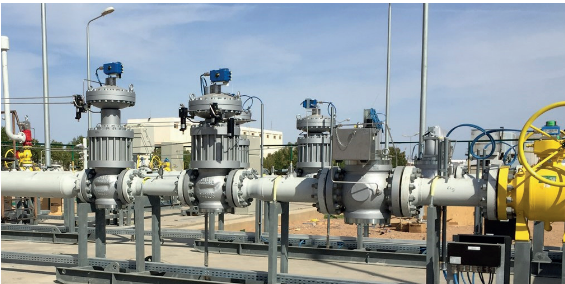
Reflux 819/FO/DB regolatore principale + Reflux 819/DB Monitor + Valvola di blocco HBC 975 | Fuel gas skid per turbina a gas in EMEA
