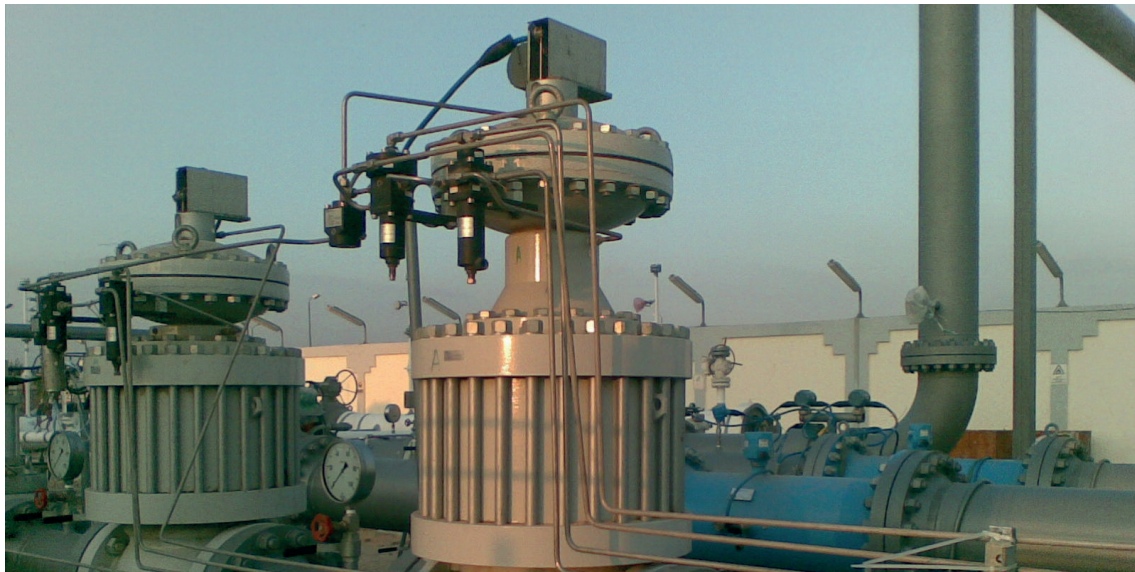
Reflux 819/FO/DB + Reflux 819/DB | Skid de gas combustible para turbinas de gas en EMEA
